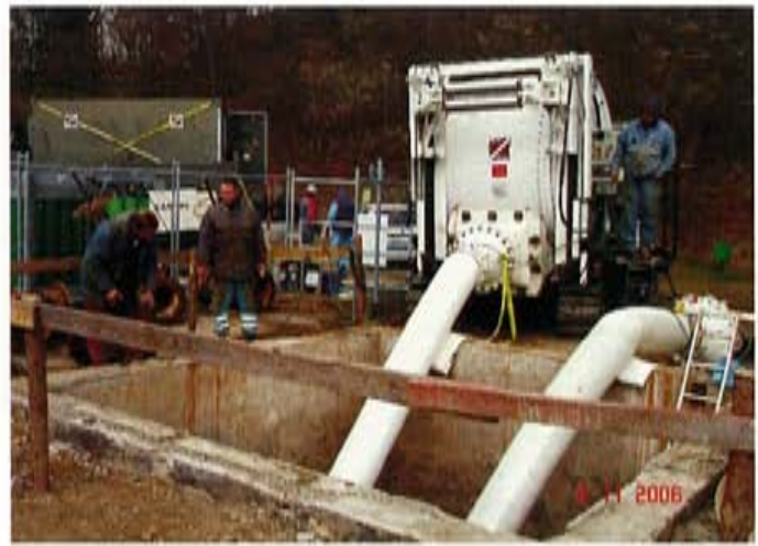
Bild 6: Sanierung des Luznice-Doppeldükers Fig. 6: Refurbishing of the Luznice double culvert
