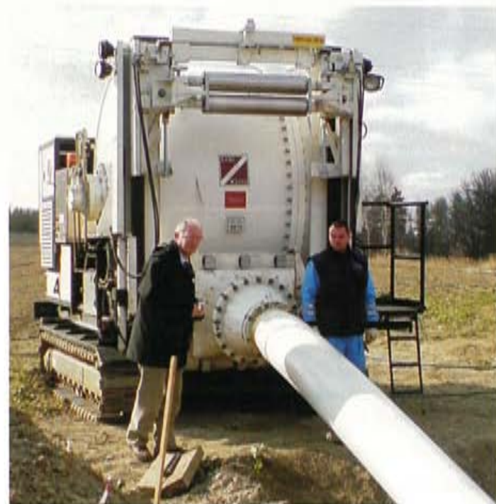
Bild 1: Gewebeschlauchrelining in Tschechien, Dr. Dec Downey (links im Bild), Vizepräsident der ISTT, vor der starline®HPLW-Drucktrommel
