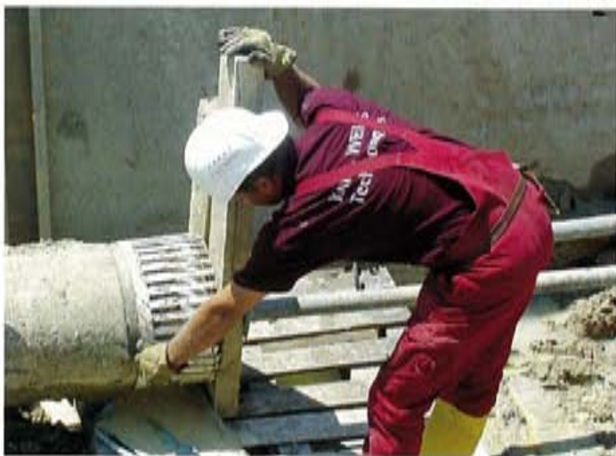
Bild 8: Abbau des Fangkorbs für den Gewebeschlauch nach erfolgter Aushärtung in der Zielbaugrube
