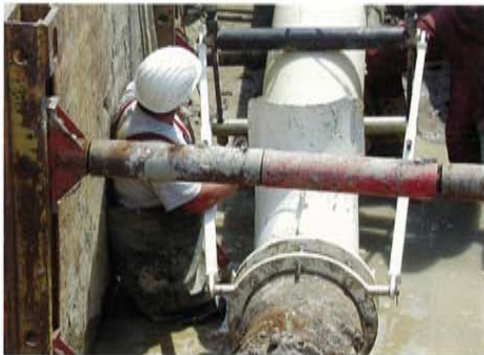
Bild 7: Arbeiten unter erschwerten Bedingungen
