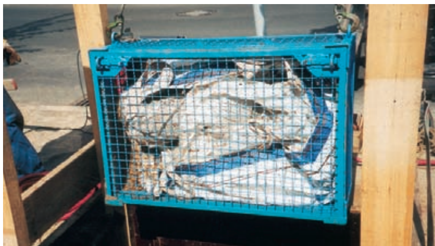
Abb. 8 Sicheres Bergen des geschlossenen Kunststoffesacks mit AZ-Fragmenten durch eine Gitterbox
