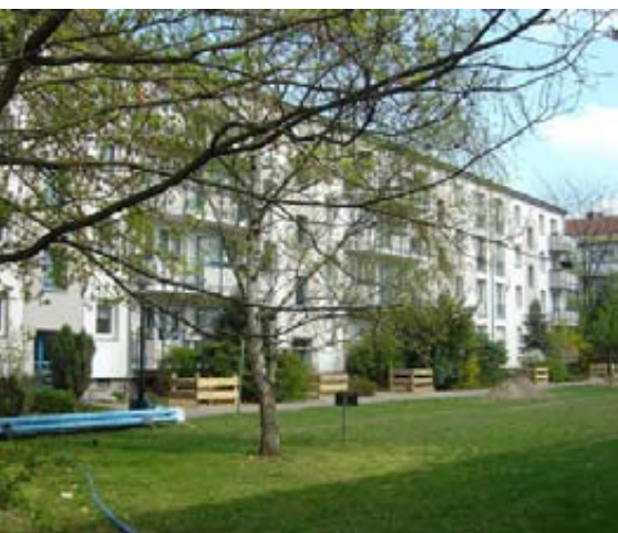
Abb. 5 Baumaßnahme zur Auswechslung einer AZ-Rohrleitung DN 100 gegen DN 100 aus GGG in Berliner Wohngebiet. Es werden nur kleine Baugruben an den Hausanschlüssen benötigt.
