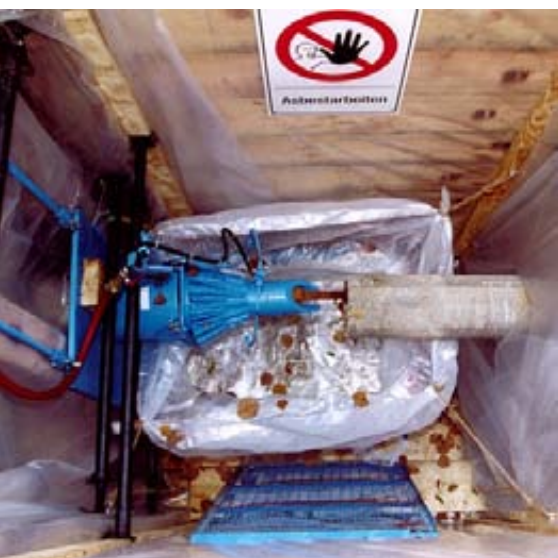
Abb. 7 Zwischenbaugrube für das Ausbauen der AZ-Rohre mit Spaltkegel und Wassersprüheinrichtung
