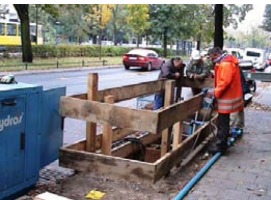
Abb. 6 Bedienung der Rohrziehanlage ohne Betreten der Baugrube vom Baugrubenrand aus
